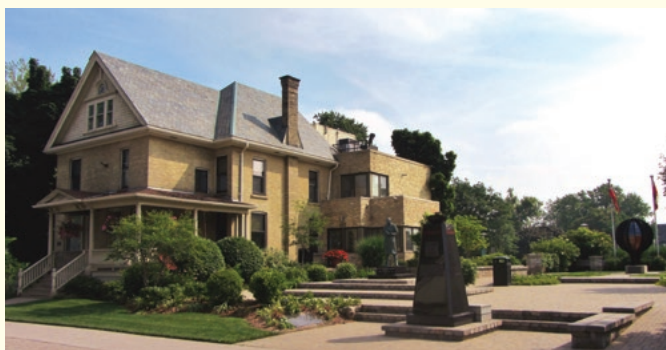
Le square Frederick Banting : à gauche se trouve la maison, au premier plan, la Flamme de l'espoir sur son socle de granite, et au fond, à droite, le globe. Entre la maison et la flamme, on aperçoit la statue de Banting.
